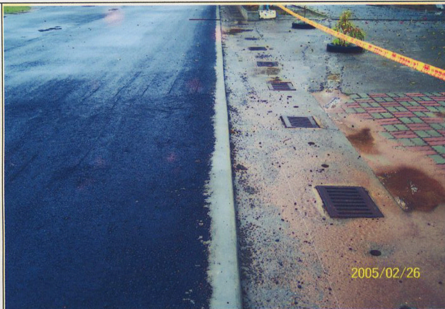
外緣石修補後
