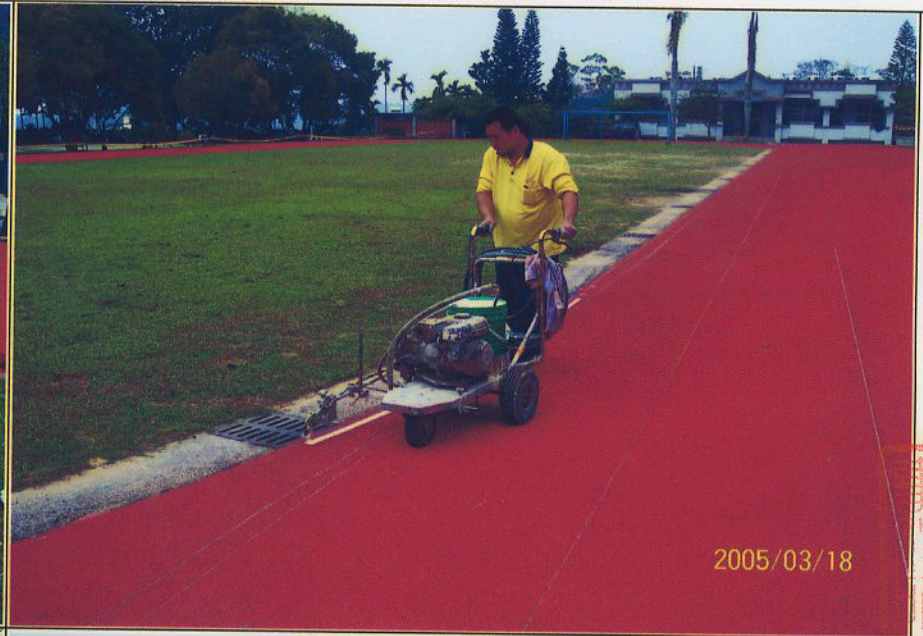
橡膠面層完成並劃線
